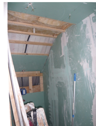
DG Bad Dusche Ausbau
