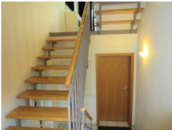
Zugang Keller- Waschküche
